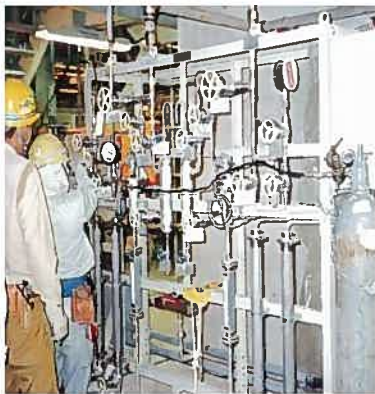
計装配管工事
