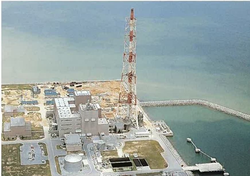
石川火力発電所
