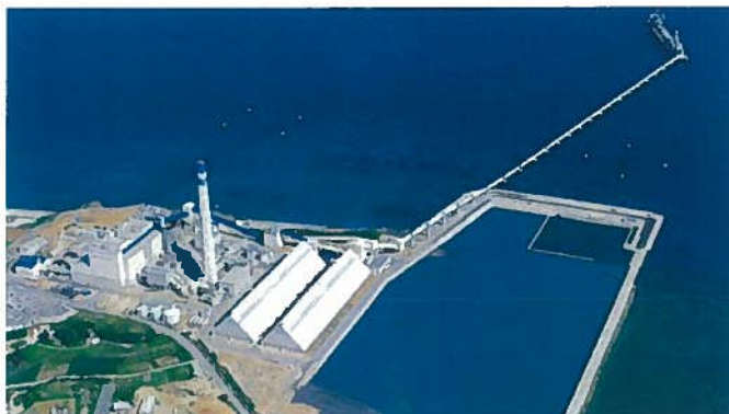
具志川火力発電所(平成7年)
