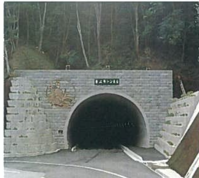
東江原トンネル
