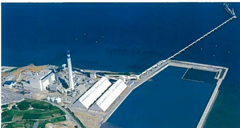
具志川火力発電所
