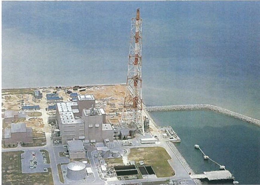
石川火力発電所
