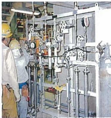
計装配管工事
