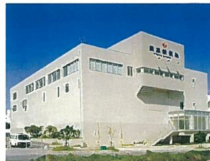
琉球新報製作センター(平成11年)
