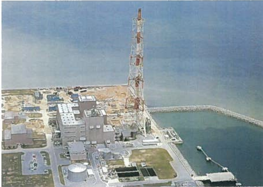
石川火力発電所
