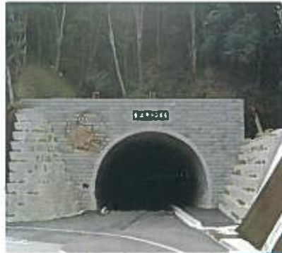
東江原トンネル
