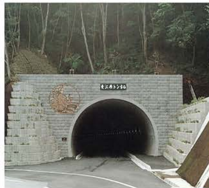
東江原トンネル
